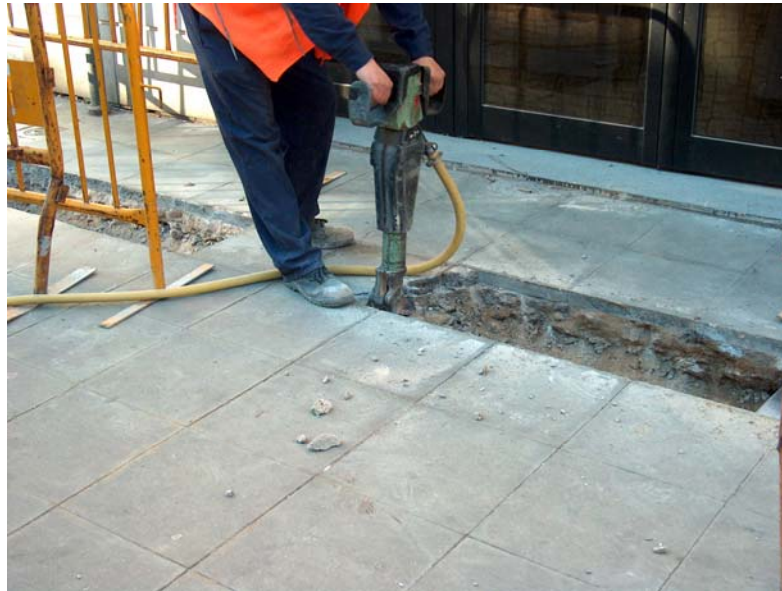
Foto 1. Obertura de la rasa amb martell pneumàtic.
