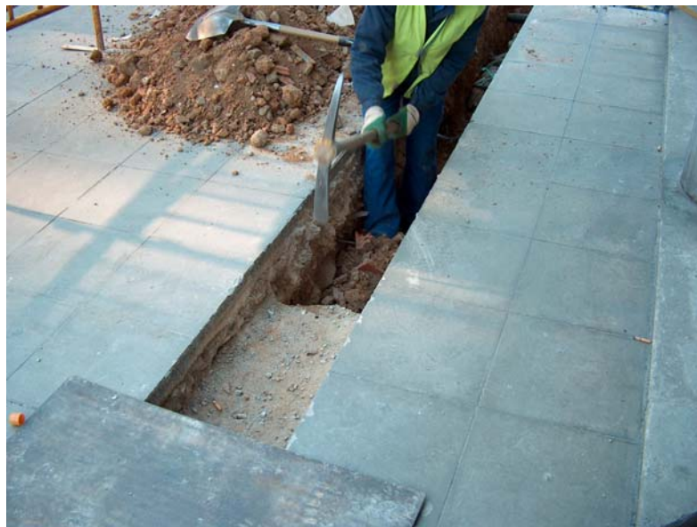
Foto 2. Obertura de la rasa a mà.
